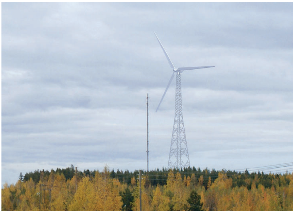
Kuva 32. Ristikkorakenteinen mastotyyppi muodostaa hyvin erilaisen maisemavaikutuksen kuin perinteinen.
