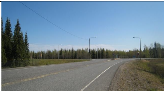
Kuva 2. Näkymä VT 4:n ja Haukiputaantien liittymästä koilliseen kohteelle 112.
