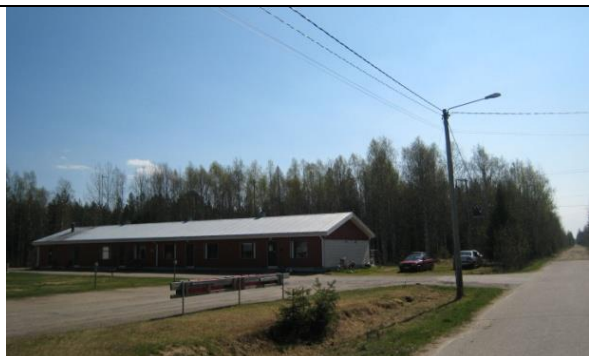
Kuva 2. Näkymä Kuivaniemen Asemakylältä etelään kohteelle 115, joka on n. 2 km päässä.
