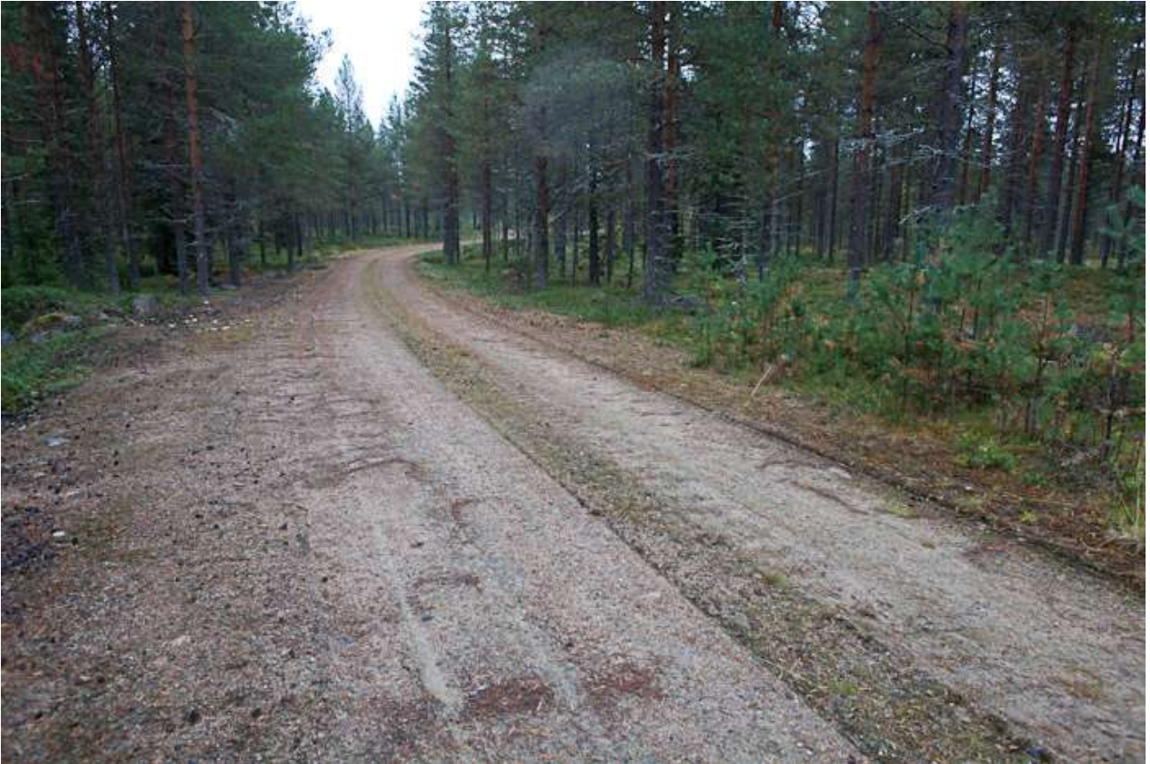
Kuva 9. Maa-ainesten ottopaikalle johtava tie on hyväkuntoinen.
