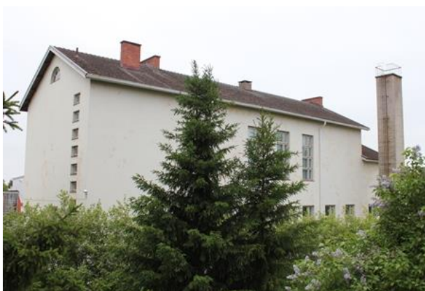
Alavieskan kansakoulun lisärakennus (1953) on esimerkki jälleenrakennusajan laadukkaasta koulurakentamisesta Pohjois-Pohjanmaalla
