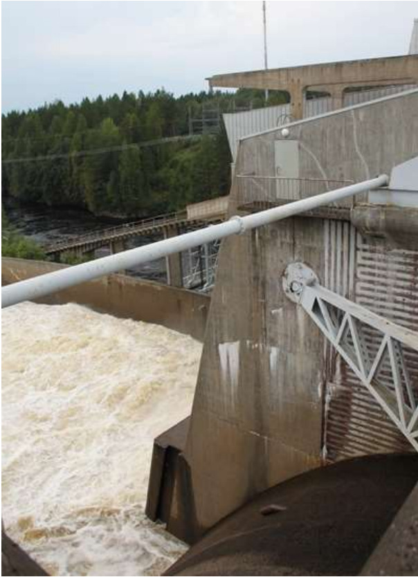
Kuva 24. Valtakunnallisesti merkittävä Nuojuan voimalaitos. (kuva: Kirsti Reskalenko)
