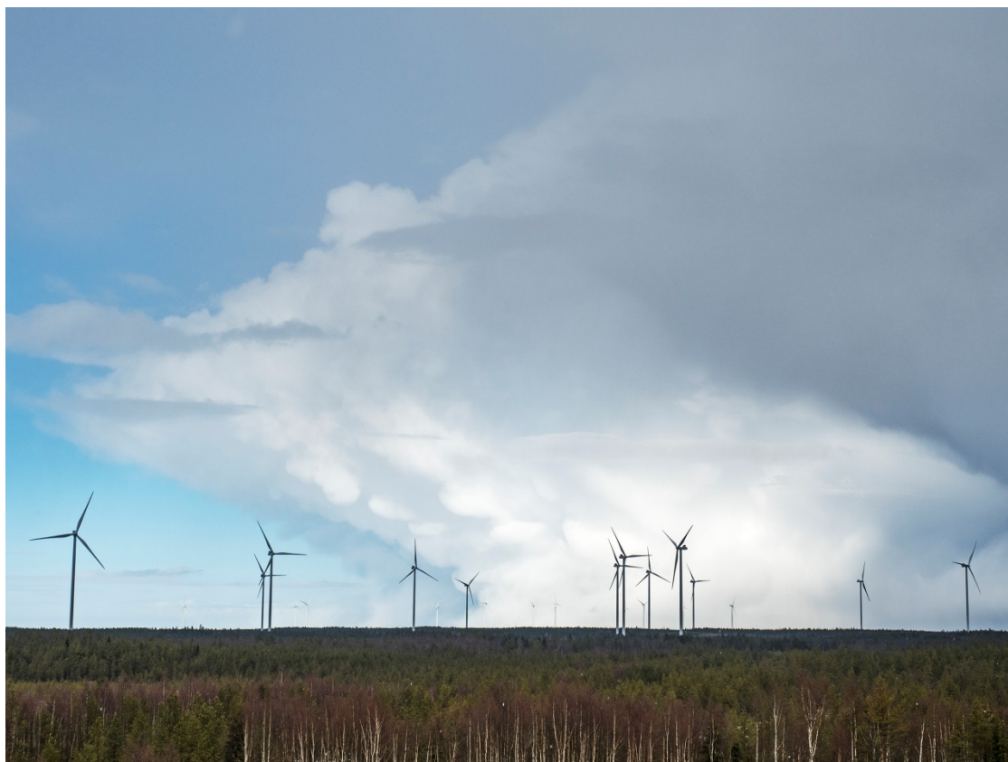
Kuva 2. Vuonna 2017 sääolosuhteet olivat kokonaisuutena hyvin poikkeukselliset, ja esimerkiksi keväällä tiheitä lumikuuroja satoi pitkälle toukokuulle saakka. Kuvassa lumikuuroja vyöryy kohti Tohkojan (etualalla) ja Mäkikankaan (taustalla) tuulivoimapuistoja.
