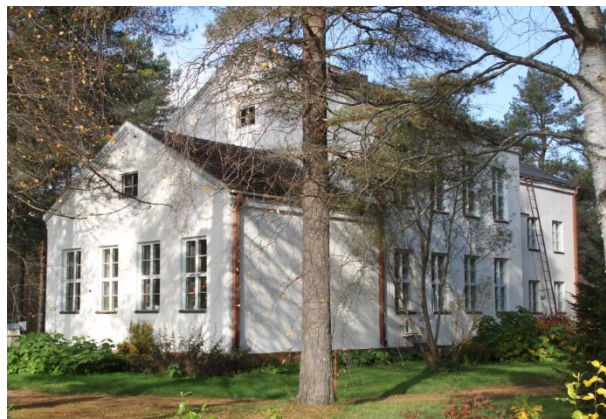
Kuva 23. Suutarinkylän entinen kansakoulu (1951) on esi-merkki jälleenrakennusajan laadukkaasta koulurakentamisesta.
