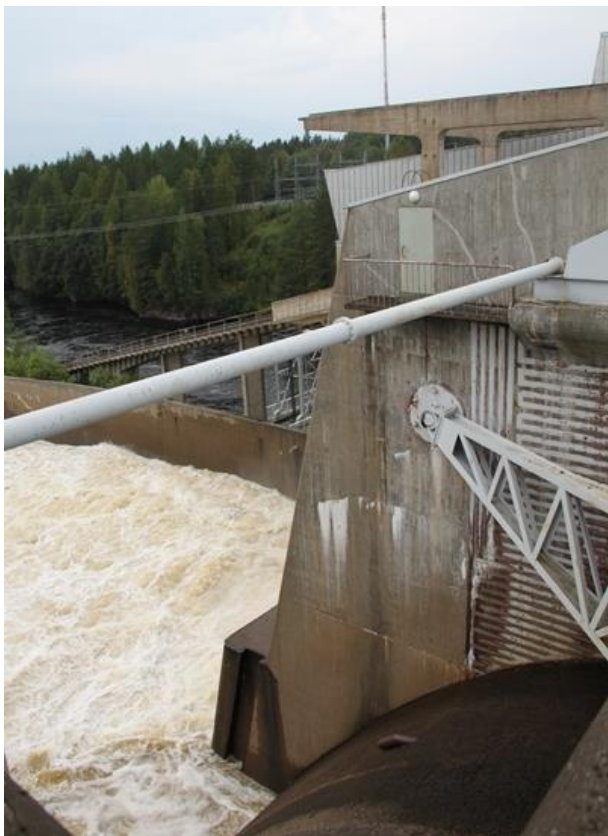
Kuva 22. Valtakunnallisesti merkittävä Nuojuan voimalaitos.
