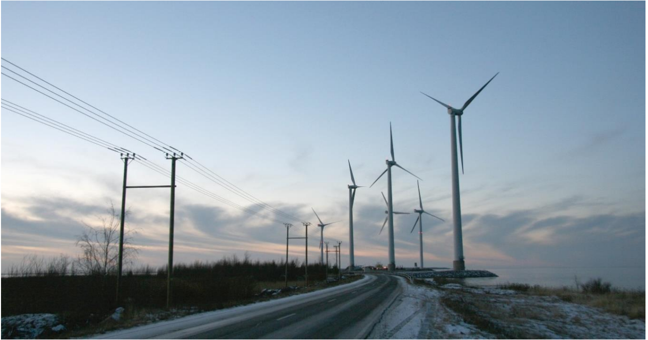
Pienialainen tuulipuisto Oulunsalon lauttarannassa. Voimalat ovat uusimpiin tuulivoimaloihin verrattuna pieniä, mutta suhteessa ympäristöönsä ne hahmottuvat kuitenkin, varsinkin läheltä tarkasteltuina, suurina. Yksittäiset tuulivoimalat muodostuvat helposti merkittäviksi maamerkeiksi maisemassa. (Kuva: Riitta Kosonen)
