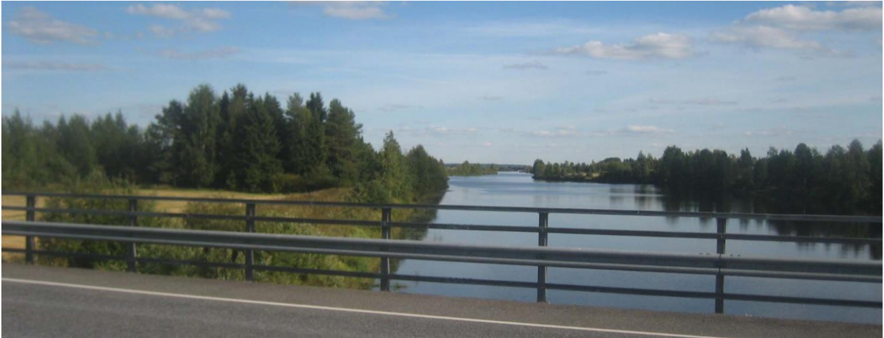
Vesistöjen yli johtavat sillat hahmottuvat tiemaisemassa kohokohtina. (Kuva: Kaisa Mäkinieni)
