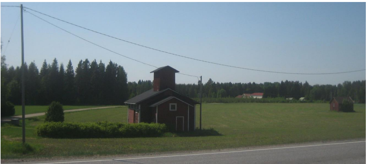
Muhoksella valtatie varressa sijaitseva vanha viljan kuivaamo erottuu maisemassa paikallisena maamerkkirakennuksena. (Kuva: Kaisa Mäkinie)
