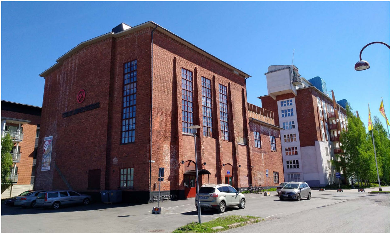
Oulun Kiipeilykeskus toimii vanhassa voimalarakennuksessa. (Kuva Kaisa Mäkinieni)
