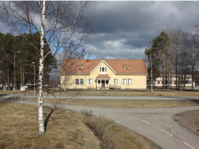
Haapajärven sairaalan pääjulkisivu nykytilassaan valtatie suunnasta katsottuna.
