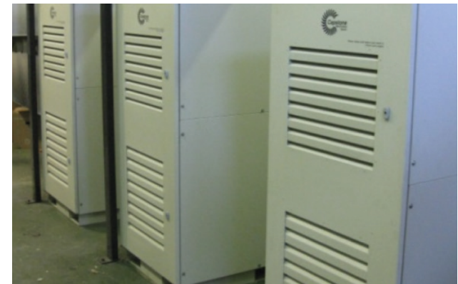
Kuva 5-3. kolmen mikroturbiinin (a' 65 kW) tuotantoyksikkö, "Capstone" (Oulun Jätehuolto)
