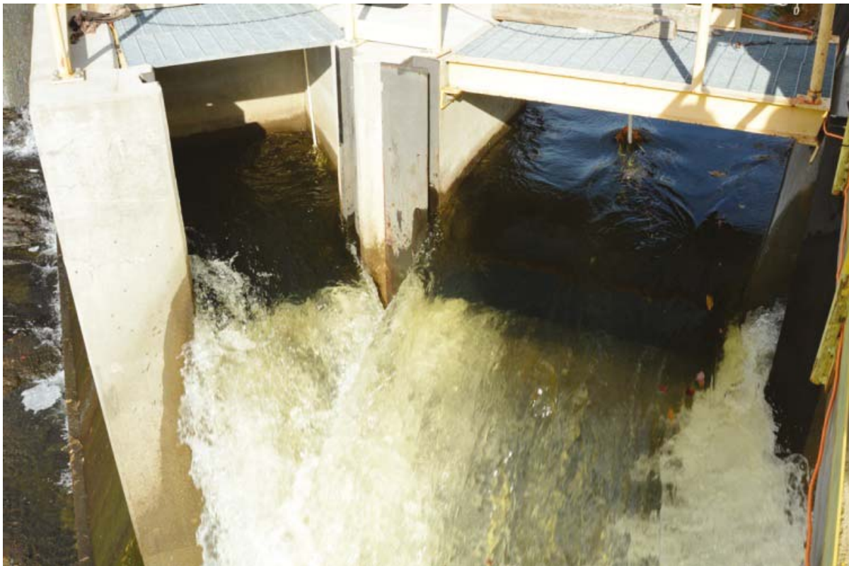
Kuva 21. Alasvaellusväylän sisäänkäynnin virtausolosuhteet ovat keskeisiä koko ratkaisun toimivuuden kannalta. Virtauksen pitää houkutella kala sisäänkäynnille ja lopulta estää kalan paluu takaisin ylävirtaan. Kuva: Panu Orell.
