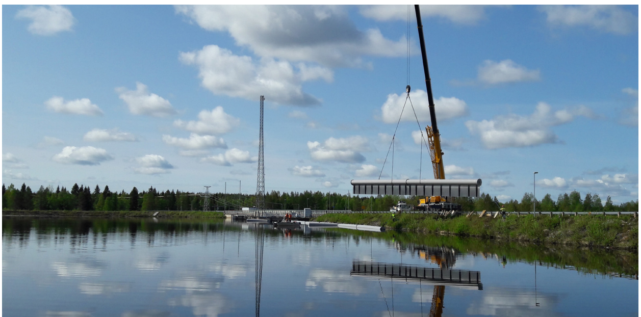
Osana Iijoen vaelluskalakärkihanketta asennettiin Iijoen Haapakoskelle Suomen ensimmäinen smolttien ohjausrakenne kesäkuussa 2019. Ohjausrakenne toteutettiin kelluvana ohjausaitana.
