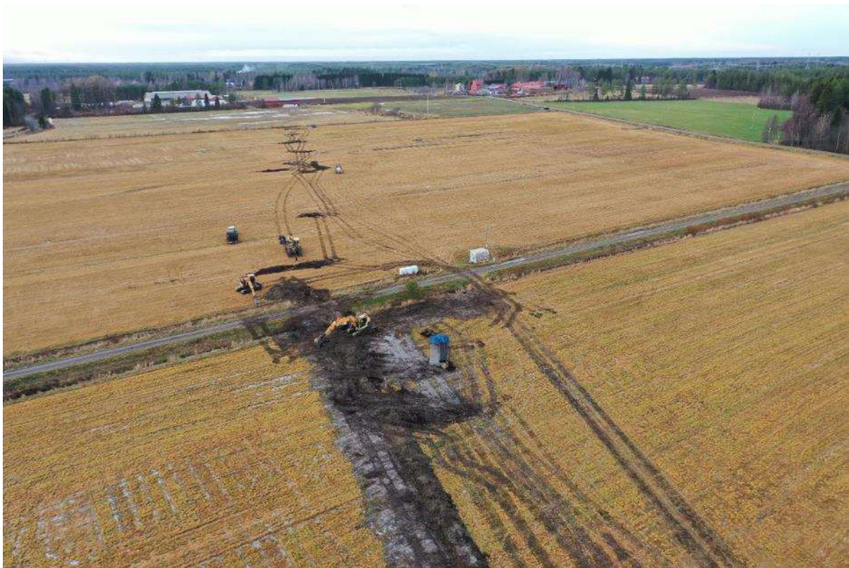
Kuva 3. Runkolinjan kaivaminen Luonnonvarakeskuksen Ruukin koeaseman NorPeat-tutkimuspellolla. Runkolinja yhdisti pellon säätösalaajituksen ja veden varastoaltaan (Kuva: Jusa Kokko, Luke).
