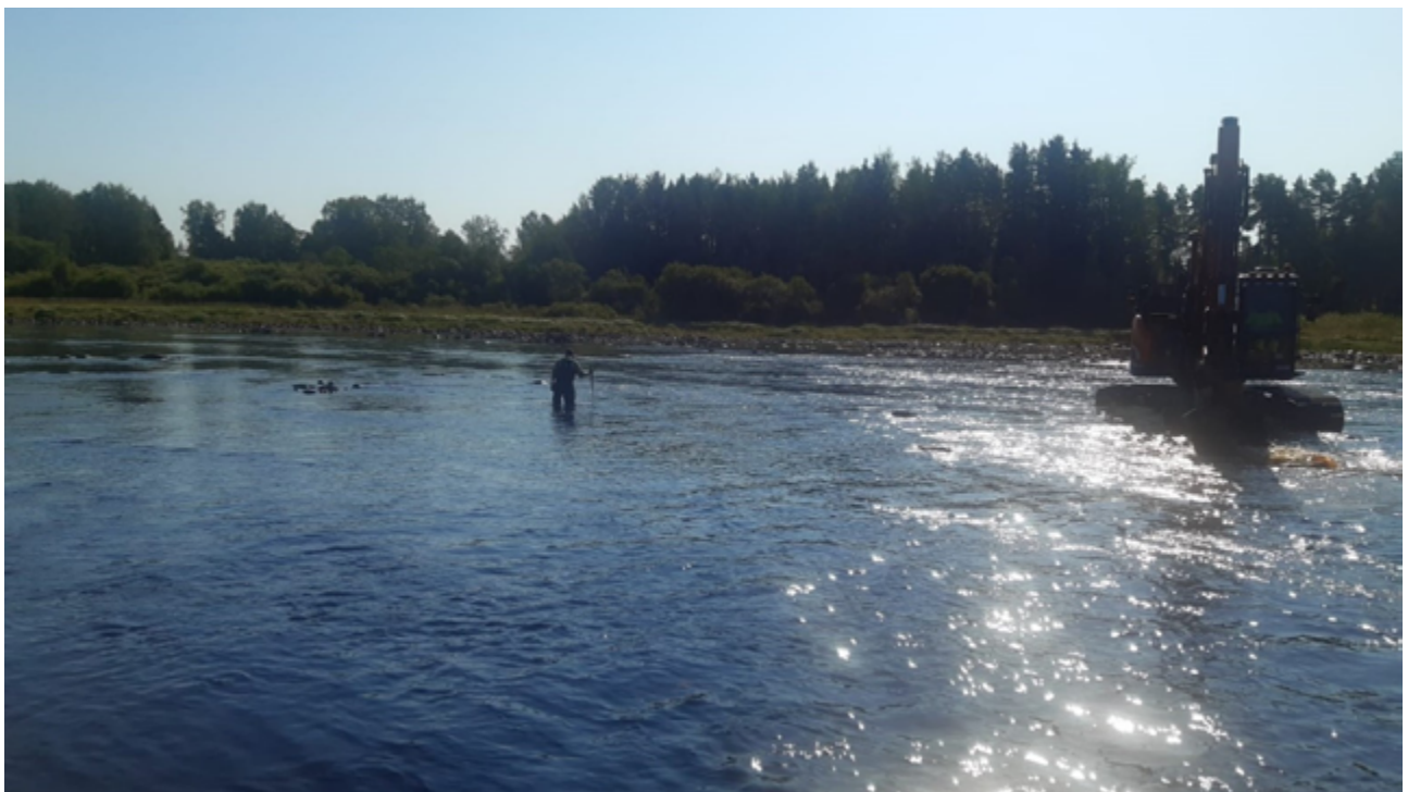
Kuva 4. Kari Kaleva. Kiiminkijokea on kunnostettu laajalti. Kuvassa kunnostukset käynnissä Sämpikoscella vuonna 2023.
