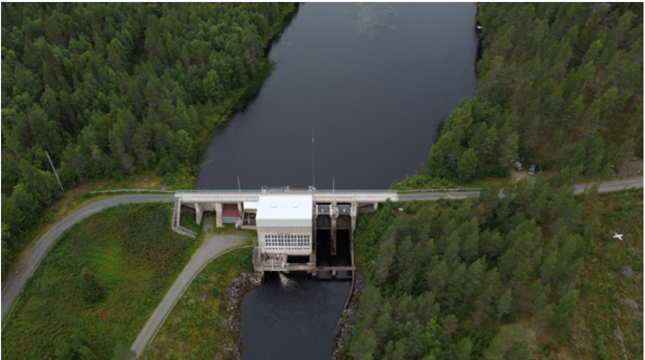
Kuva 10. Ensio Karjalainen. Myllykosken voimalaitos on poistettu käytöstä.
