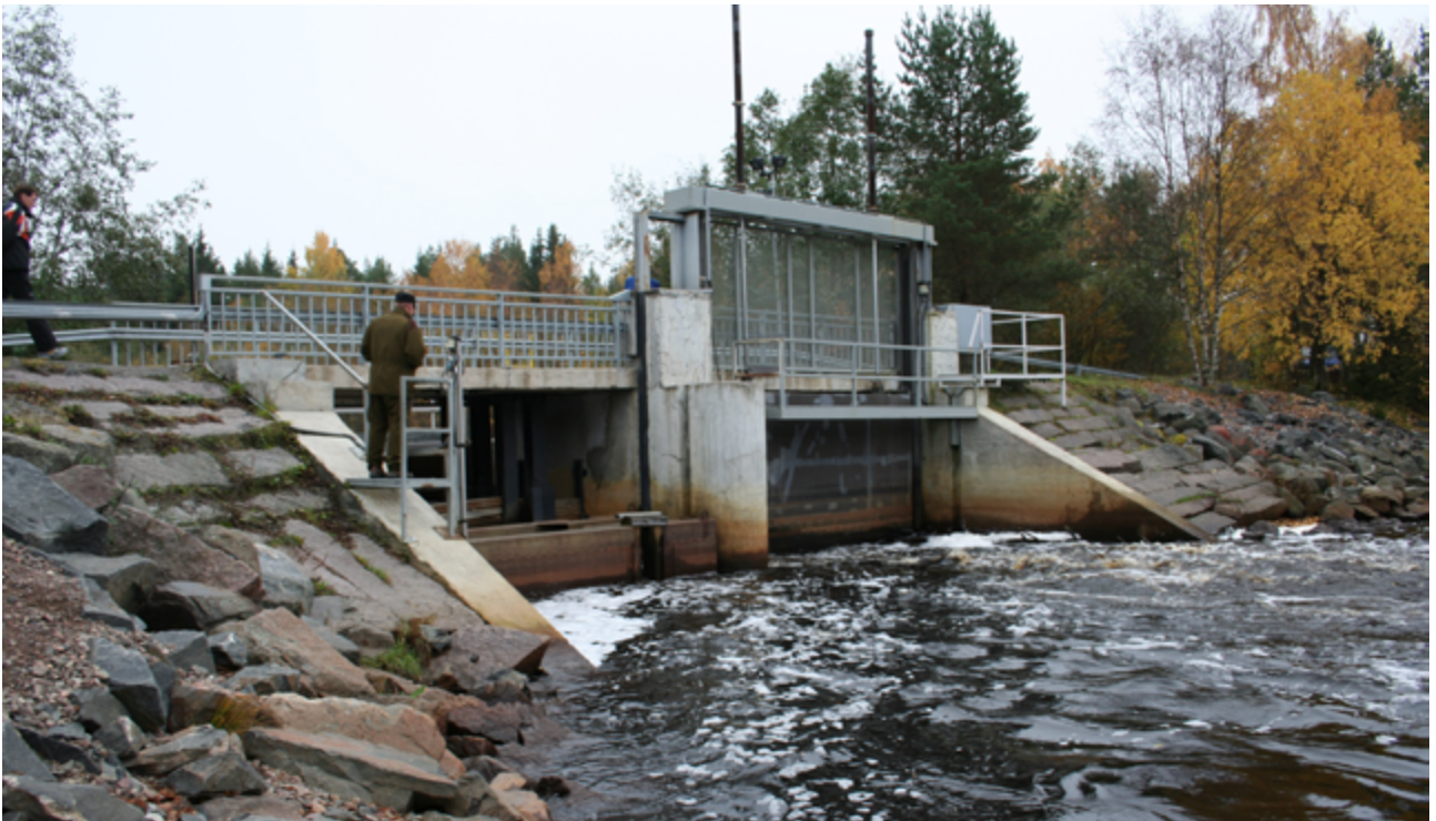
Kuva 13. Kimmo Aronsuu. Piehinginjoella on lähellä jokisuuta säännöstelypato. Padon yhteyteen on rakennettu kalatie.
